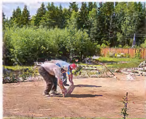
С помощью доски выравнивали поверхность почвы
