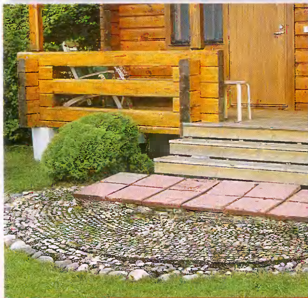
Для широких ступеней потребуется выложить большой каменный «половик»
